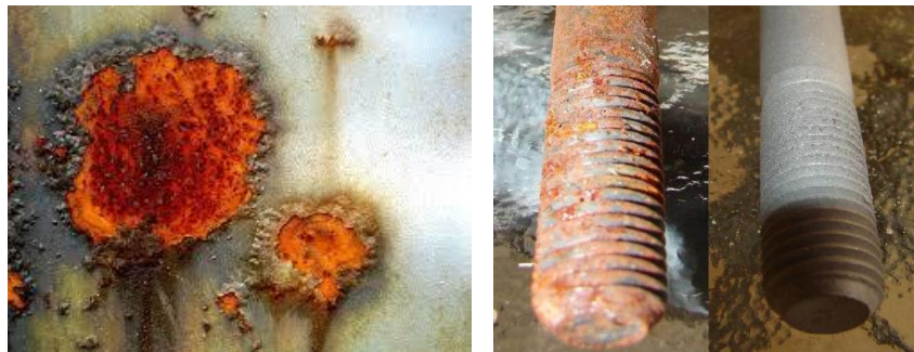
Slika 1.2.7 – 1 Primjeri korozije materijala
